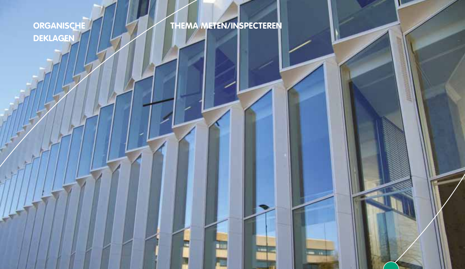
De gevel van ASR te Utrecht, gecoat onder Qualicoat-label. (Foto: Marc Maas, Alucet)
